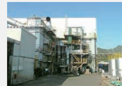
アサヒプリテック北九州工場 焼却設備
