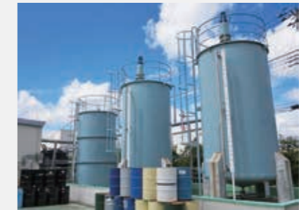
ジャパンウェイスト横浜工場 廃油リサイクル設備
