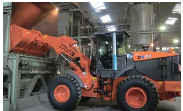
不溶化処理施設
