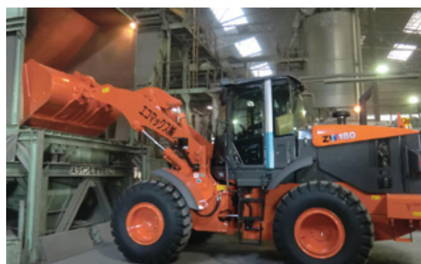
不溶化処理施設
