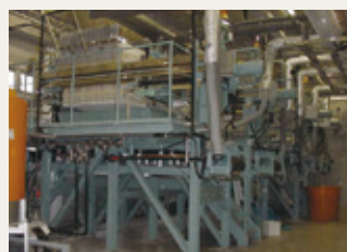
廃液処理施設
